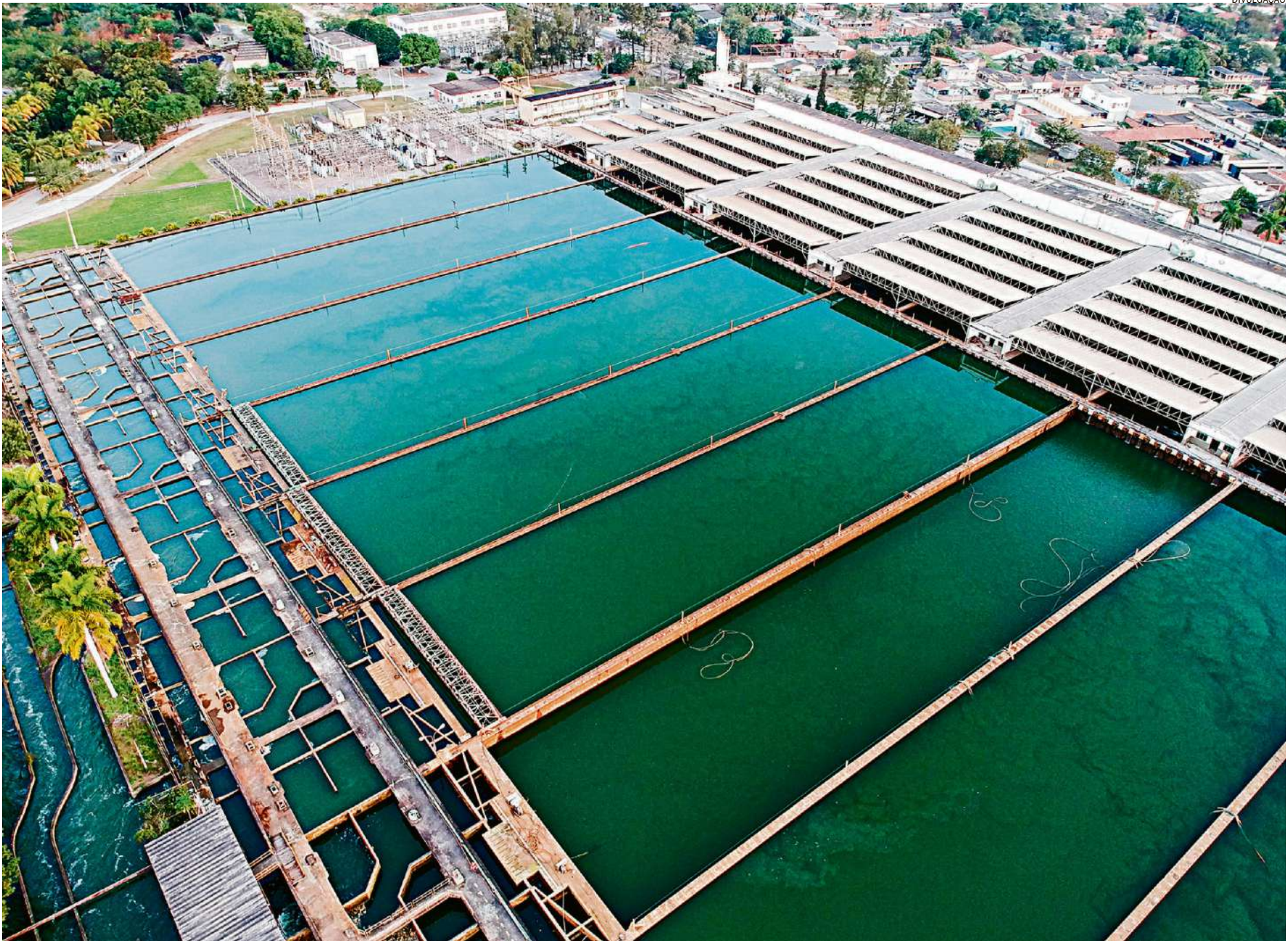
Enxurrada. A Estação de Tratamento do Guandu, operada pela Cedae: governo do estado concedeu em 2021 os serviços de distribuição de água e de tratamento e coleta de esgotos a três consórcios
