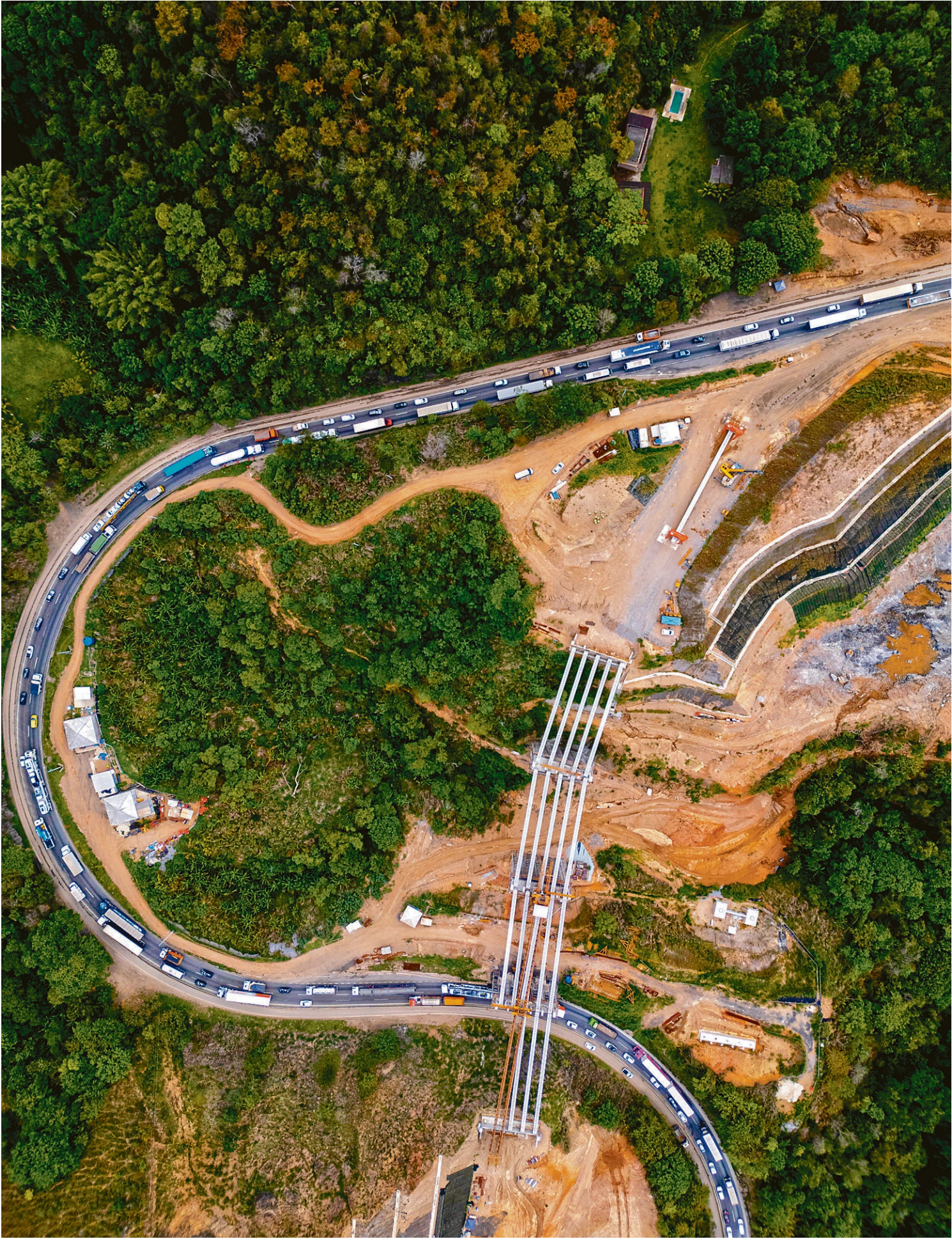
Viaduto 8. Com vigas já instaladas, última das estruturas que serão entregues no próximo trimestre mostra como viadutos reduzirão curvas ao longo da serra
