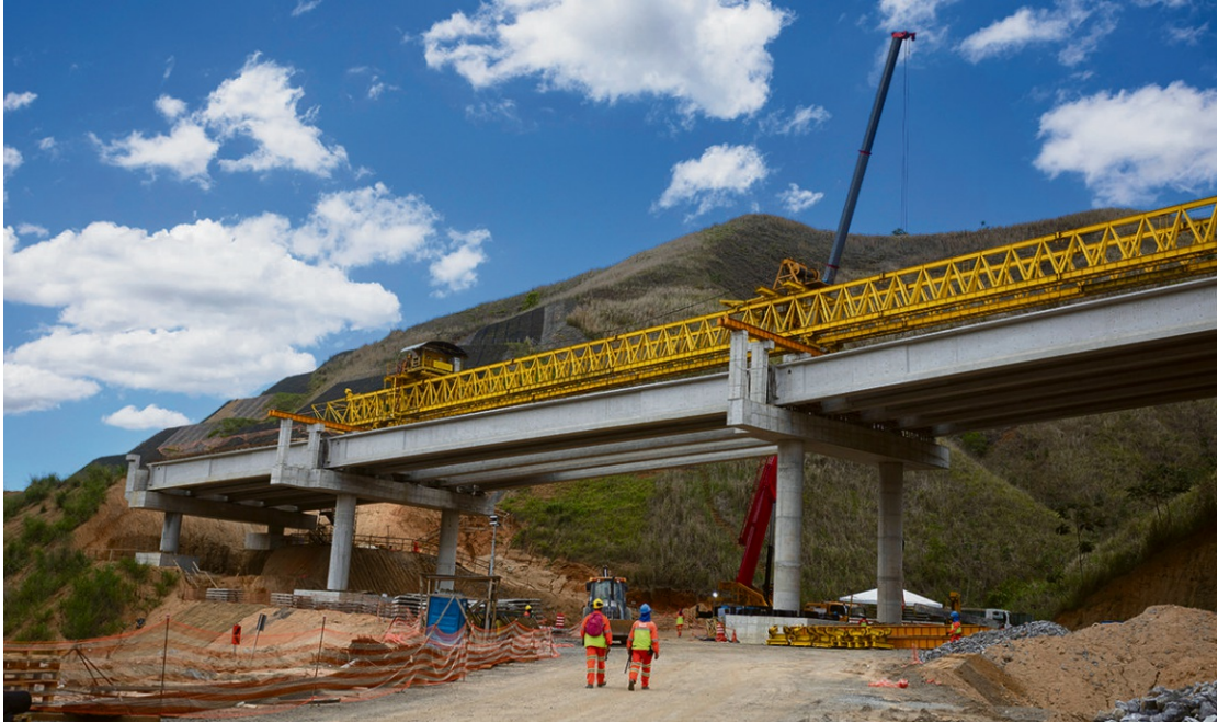
Na obra. Guindaste (ao fundo) içava vigas, posicionadas a partir das treliças. Comprimento pode chegar a 41,8 metros
