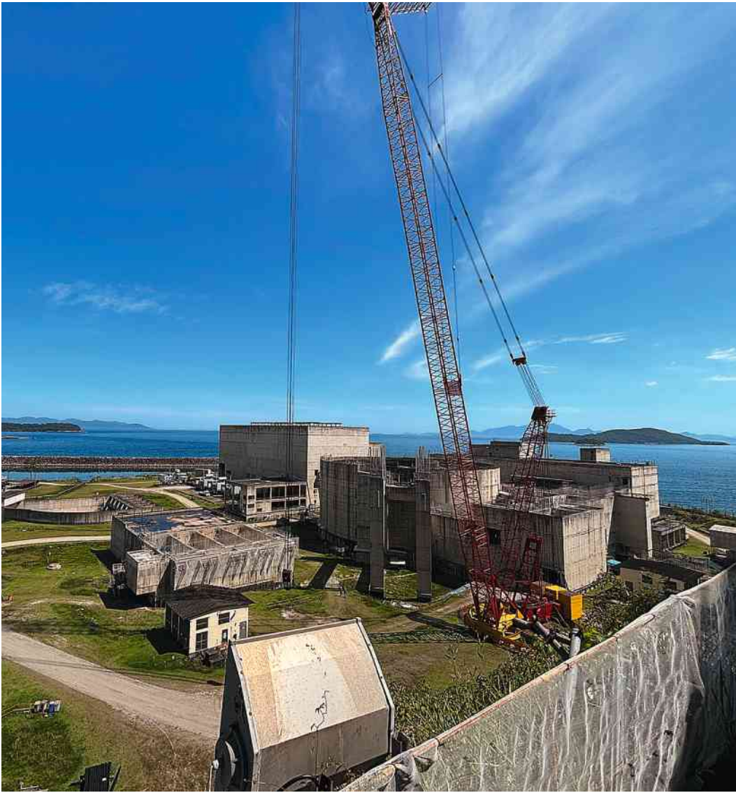
Obras da usina nuclear de Angra 3, da Eletronuclear, no Rio de Janeiro Alexa Salomao - 28.nov.2024/Folhapress
