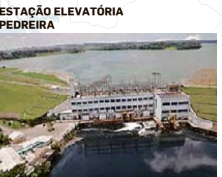
OS 20 METROS RESTANTES DE DESNÍVEL SÃO SUPERADOS COM O BOMBEAMENTO NA ESTÇÃO ELEVATÓRIA DE PEDREIRA; COM ISSO, É CONCLUÍDA A MUDANÇA DO FLUXO DA ÁGUA PARA A REPRESA BILLINGS
