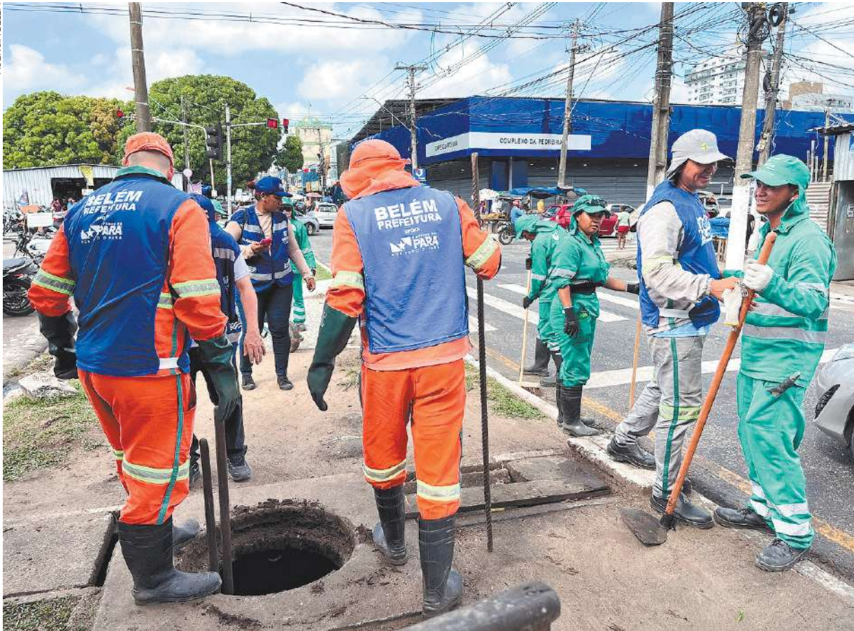
Equipes da prefeitura finalizam a obra de reforma do mercado e da feira da Pedreira
