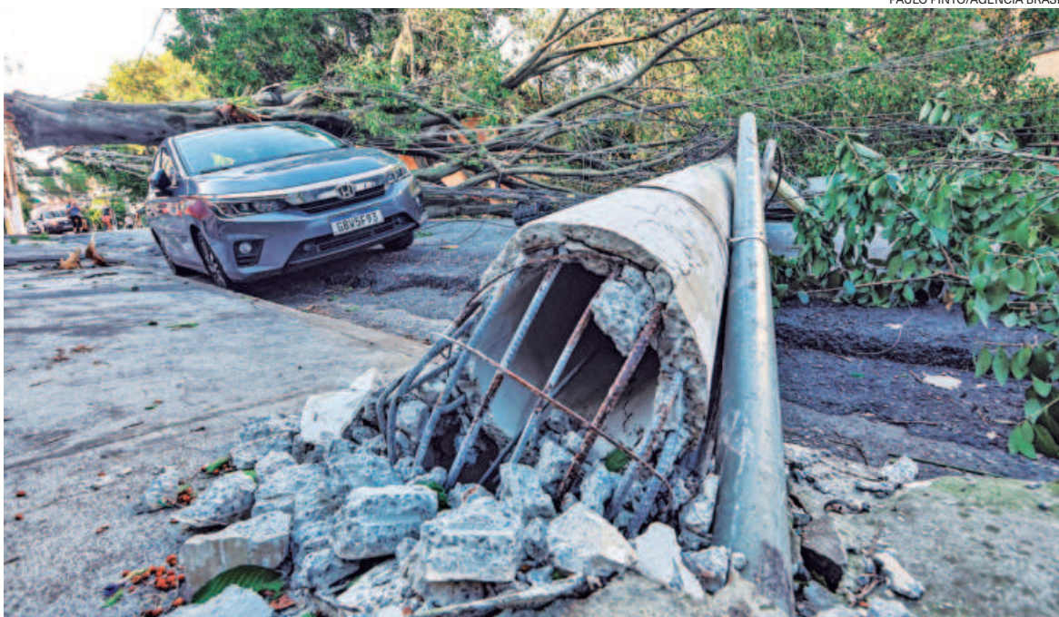
As rajadas de vento derrubaram árvores e lançaram galhos e outros objetos sobre a rede elétrica
