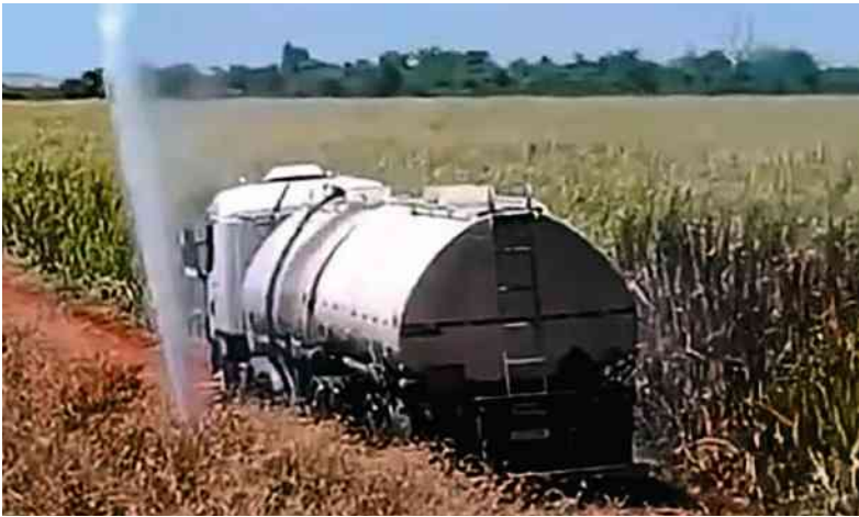
Gasolina jorra de duto da Transpetro perfurado durante tentativa de furto em Orlândia, no interior de São Paulo, em outubro de 2025 Reprodução
