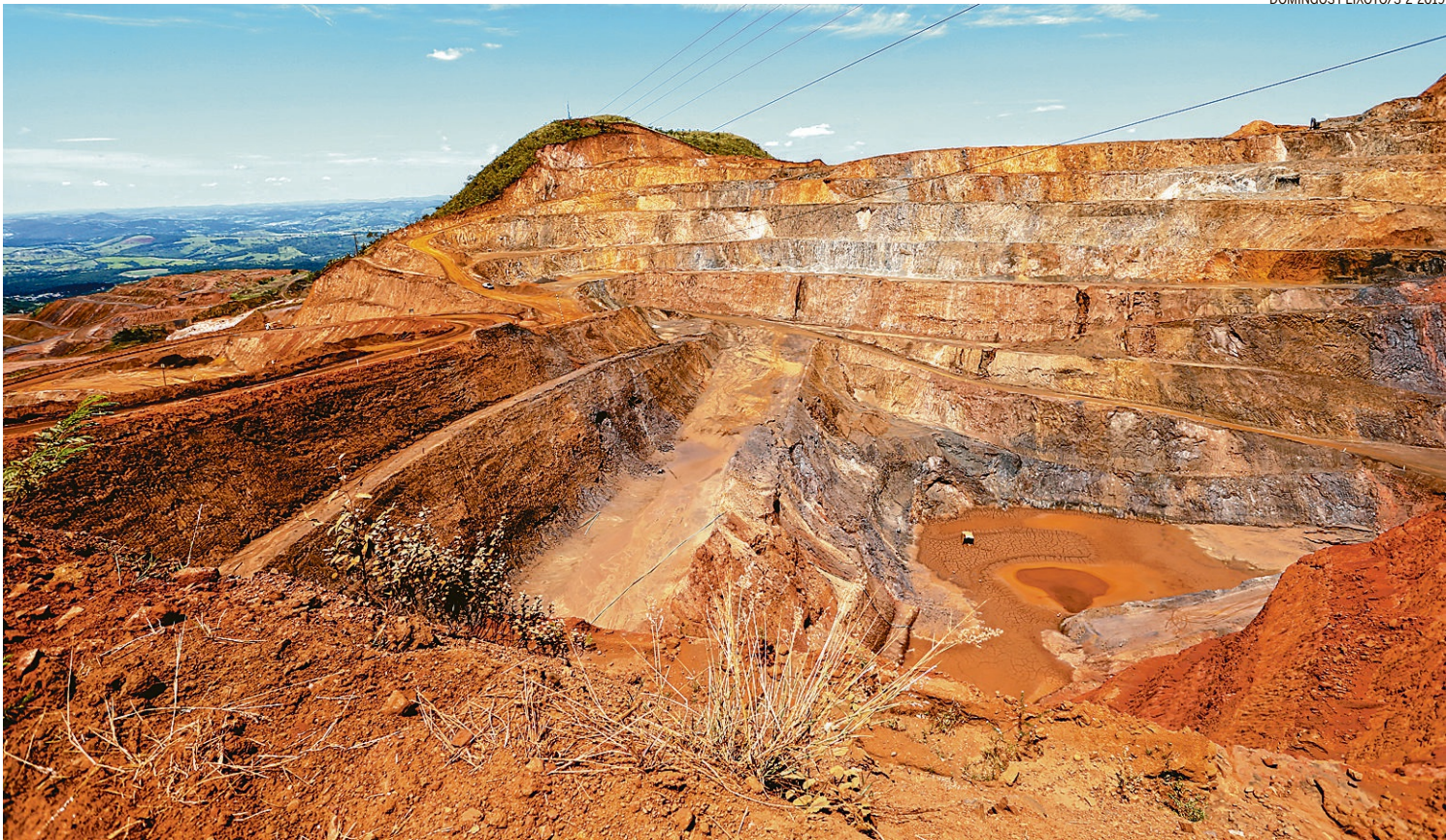
Risco. Mina em Brumadinho (MG): estrutura a montante tem um modelo considerado mais frágil porque os rejeitos ficam empilhados uns em cima dos outros
