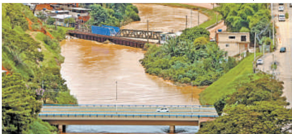
ÁGUAS DO RIO PARAIBUNA SUBIRAM ATÉ ATINGIR PONTES QUE LIGAM OS DOIS LADOS DA CIDADE
