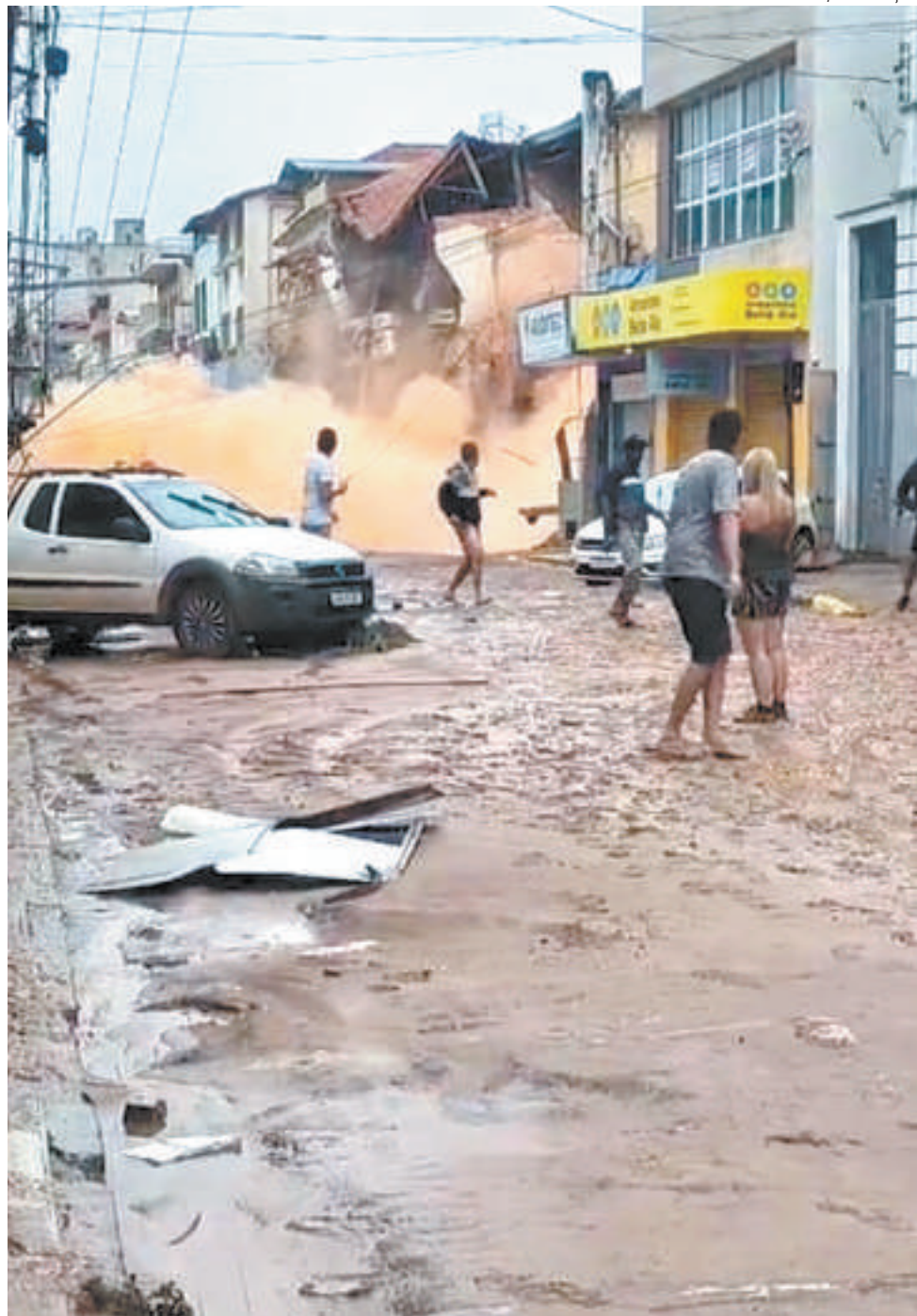
PRÉDIO DESMORONA NA AVENIDA CRISTIANO ROÇAS, EM UBÁ, DESPRENDENDO NUVEM DE POEIRA
