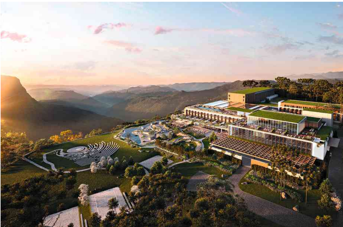
Projeção 3D mostra como deve ficar o Laje de Pedra, em Canela (RS), com a bandeira Kempinski Divulgação
