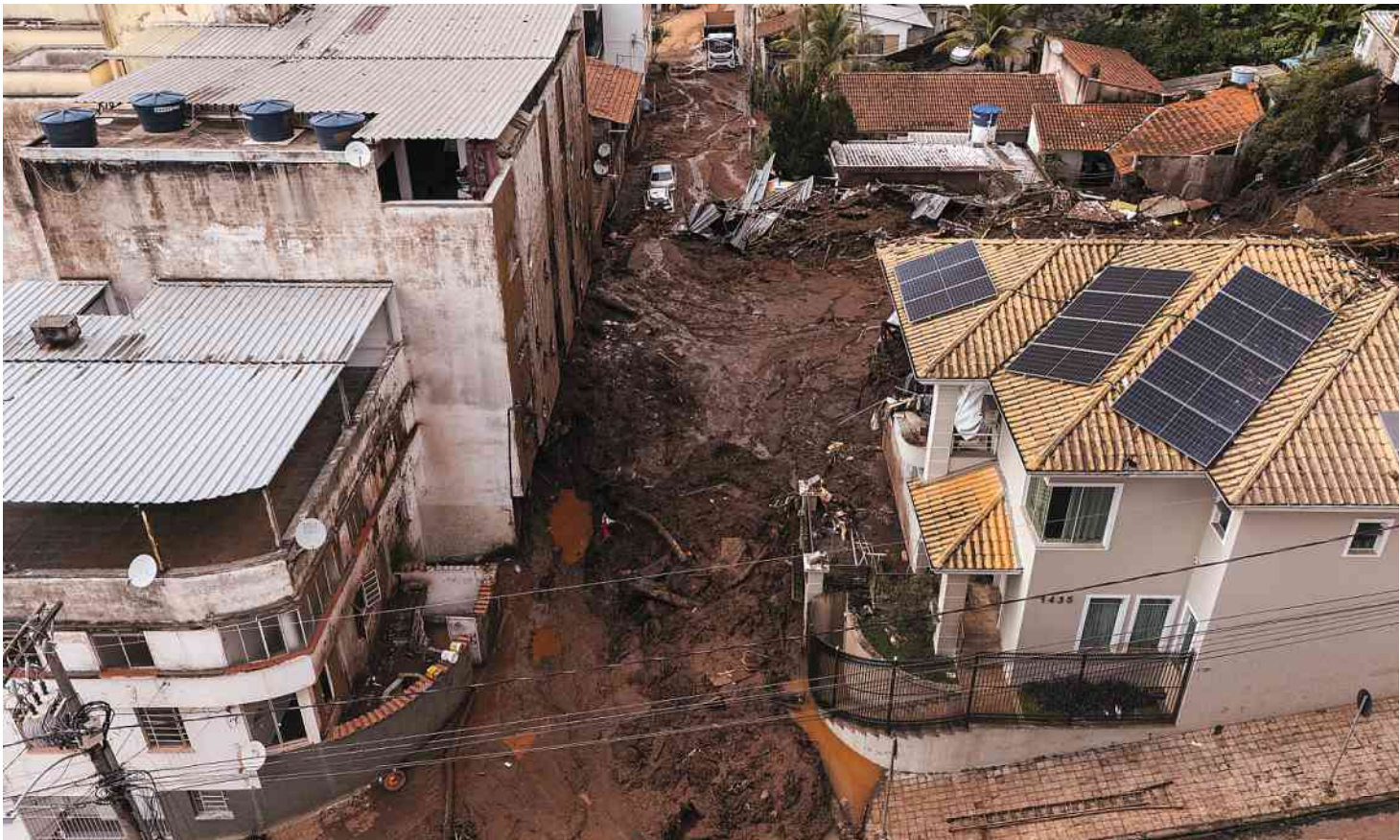
Desabamento após forte chuva no bairro Paineiras, em Juiz de Fora (MG) Eduardo Anizelli/Folhapress
