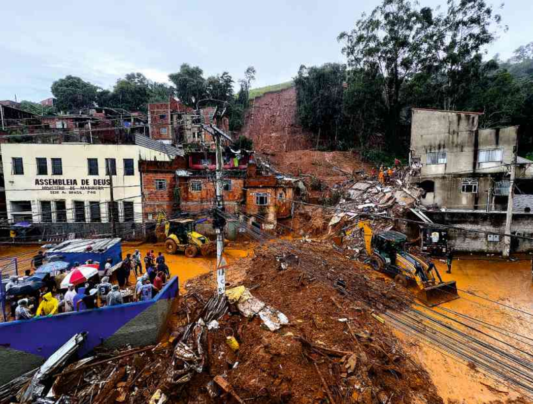
Área com deslizamento de terra após chuva em Juiz de Fora (MG) Eduardo Anizelli - 24.fev.26/Folhapress
