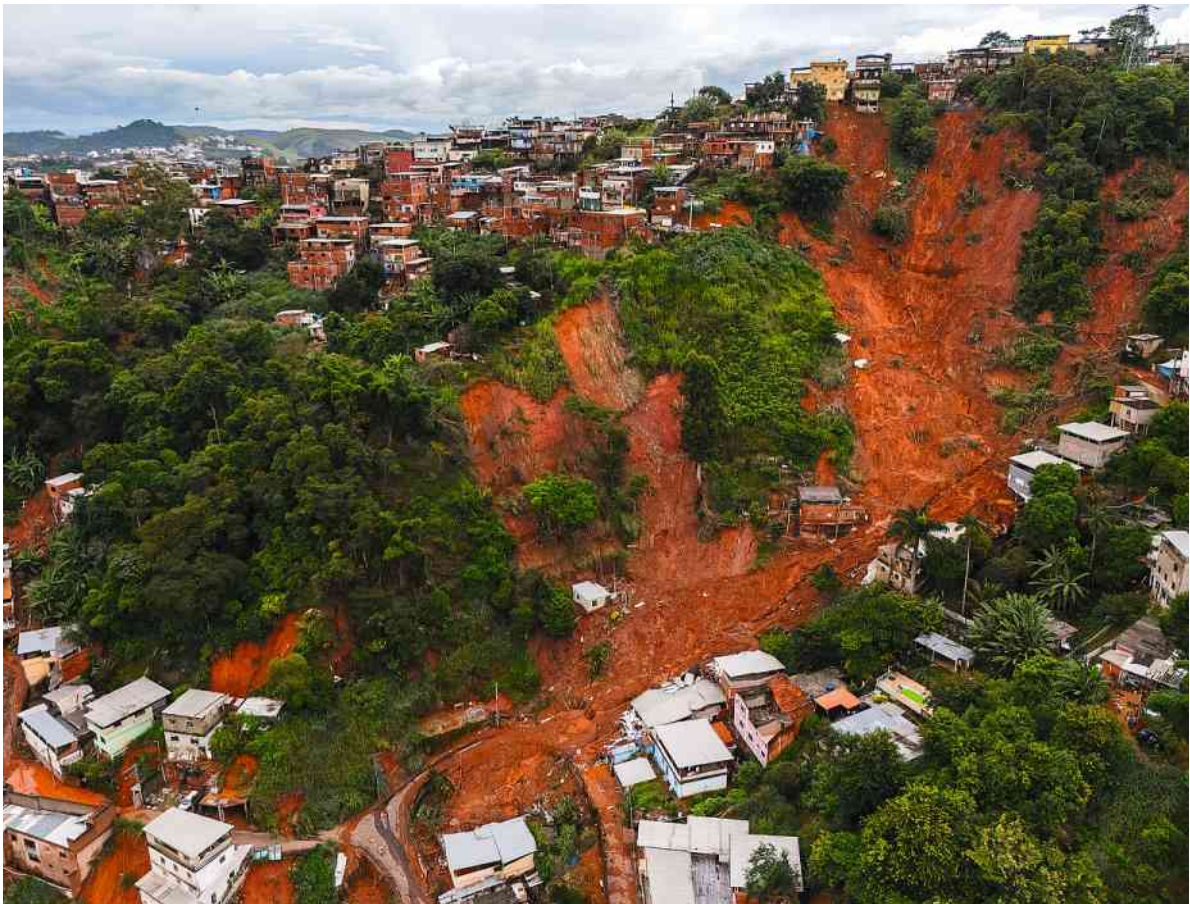
Deslizamento de terra no bairro Três Moinhos, em Juiz de Fora (MG) Eduardo Anizelli - 26.fev.26/Folhapress
