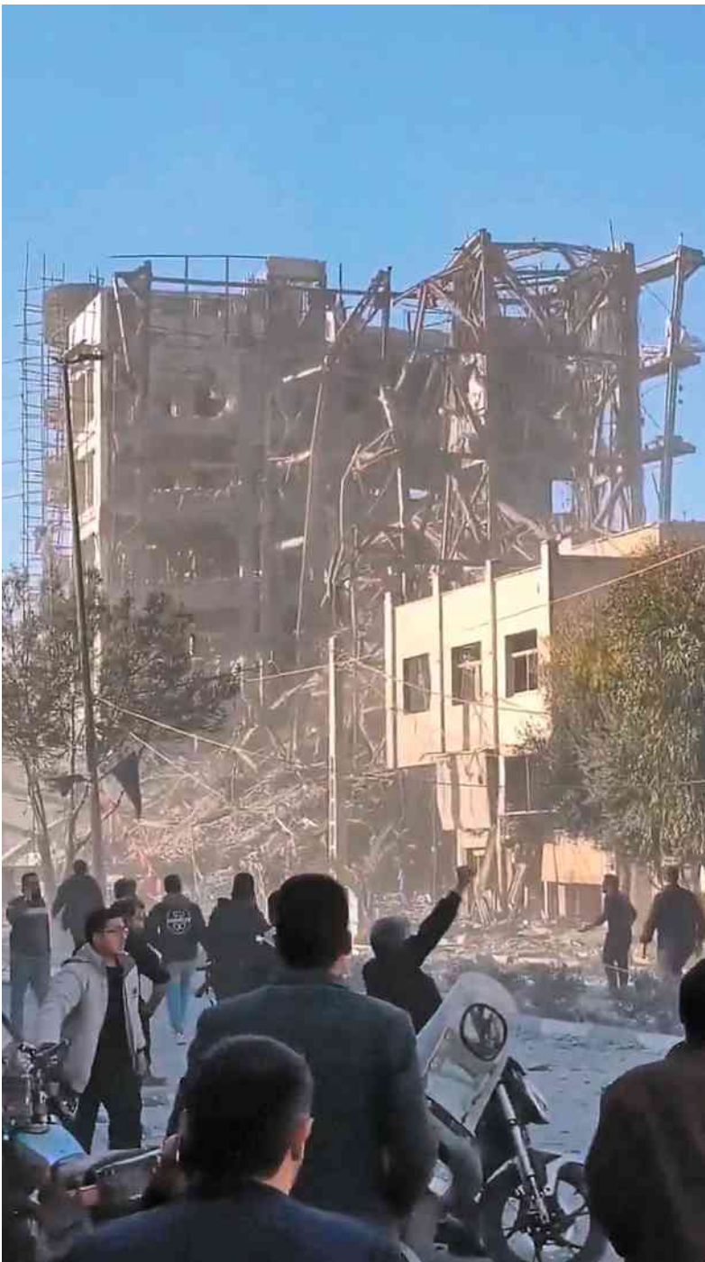
Pessoas observam destroços do prédio da Assembleia de Especialistas, após ataques em Qom, no Irã Redes Sociais via Reuters
