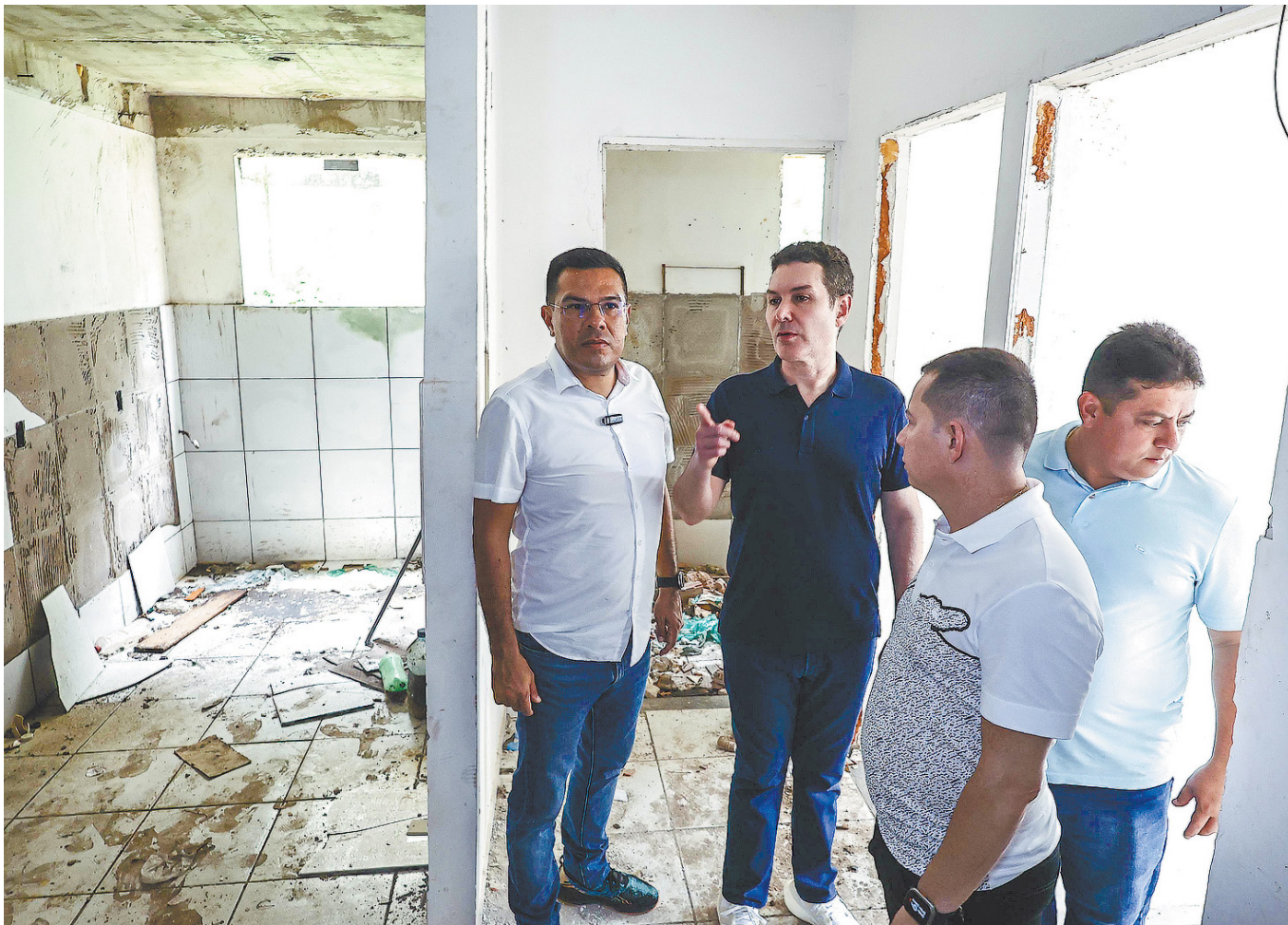
Ministro Jader Filho durante visita ao Viver Pratinha, que já estava 99% concluído quando foi invadido, em setembro de 2021. Obras foram retomadas para a entrega das unidades.
