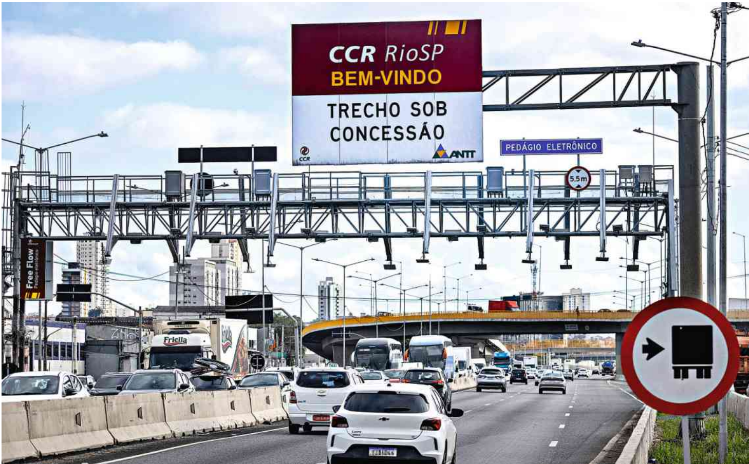
Pedágios eletrônicos free flow na saída de SP instalados na rodovia Presidente Dutra Eduardo Knapp - 10.nov.25/Folhapress
