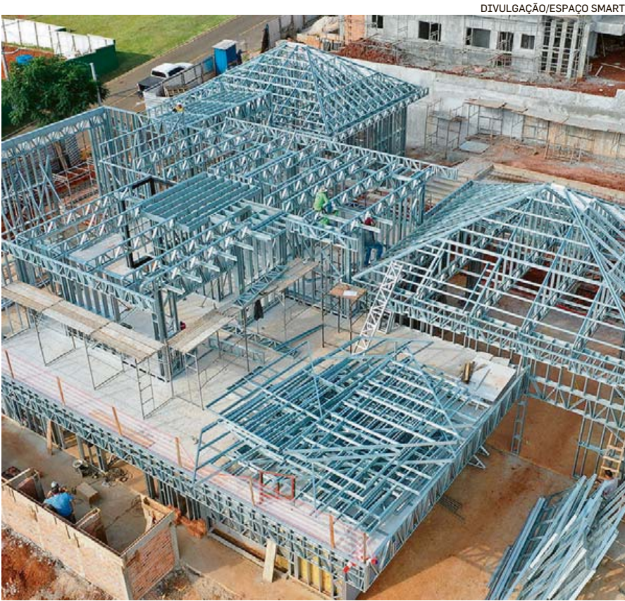
Canteiro de obras com estrutura metálica ‘steel frame’ fabricada pela Espaço Smart
