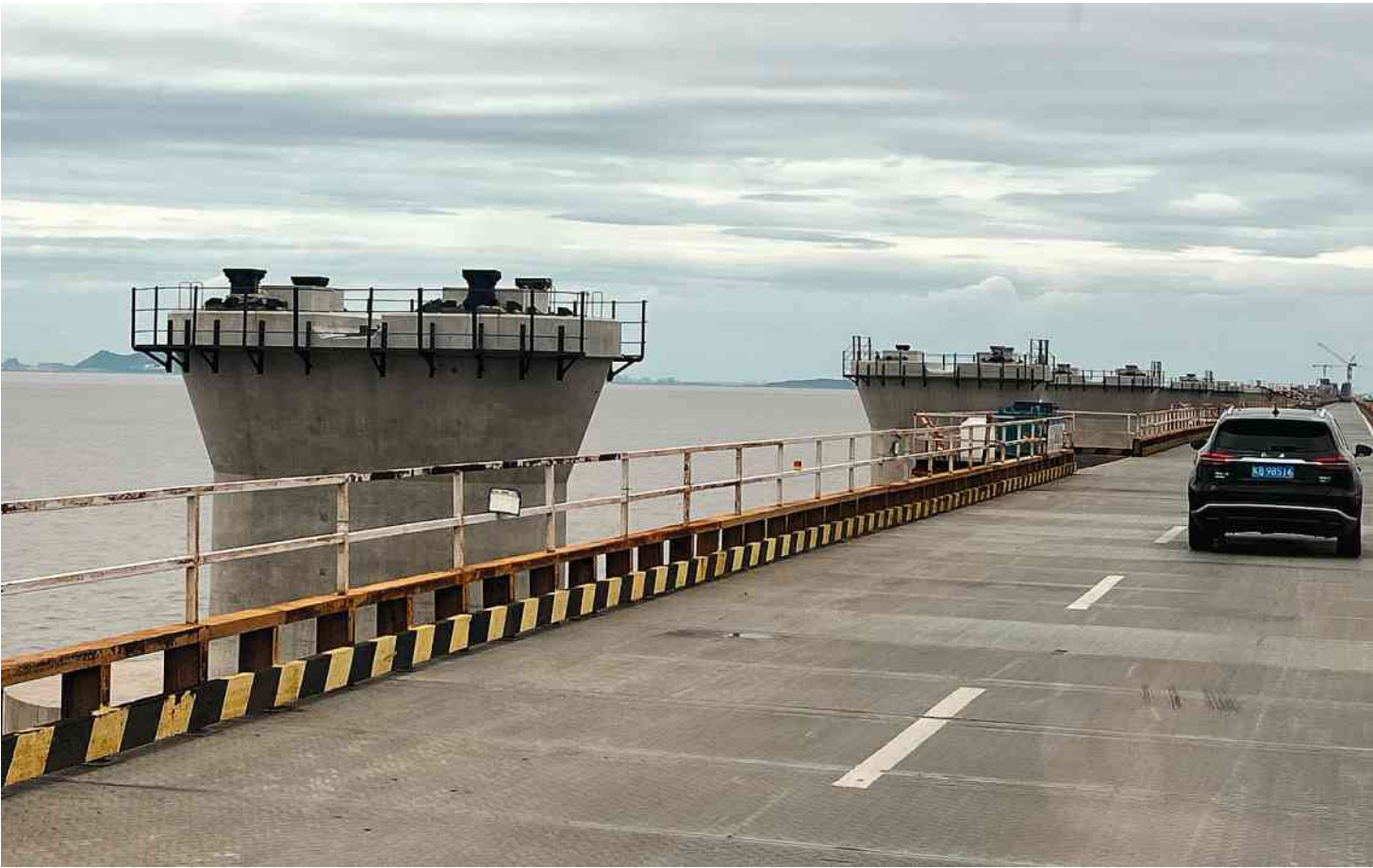
Passarela de aço provisória usada na China para apoiar construção de pontes, semelhante à que será construída no Brasil Divulgação
