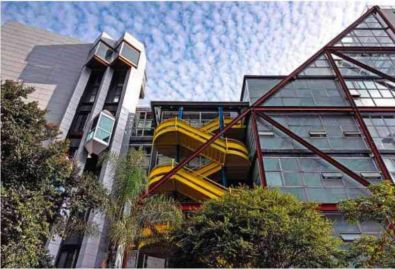
Fachada da Escola Panamericana de Artes, hoje utilizada pela ESPM, no bairro de Higienópolis, no centro de SP Pedro Affonso - 16.abr.26/Folhapress
