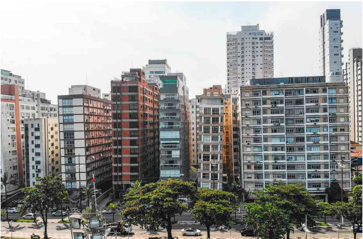
Prédio torto em Santos devido ao solo arenoso e fundações insuficientes Karime Xavier - 8.mai.23/Folhapress
