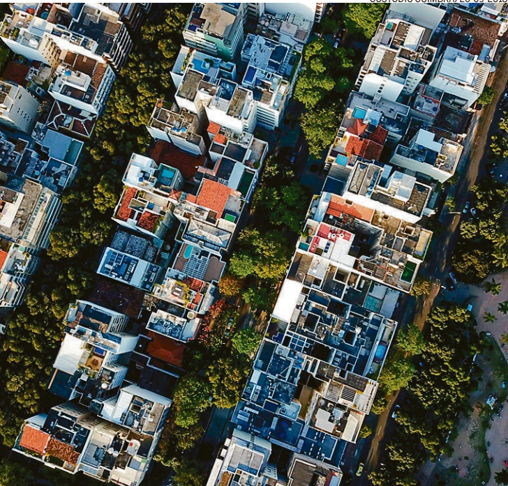
Expansão. Construções no topo de edifícios: lei permite regularizar puxadinhos
