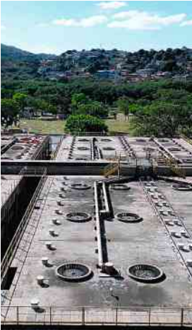
Estação de esgoto da Copasa em Belo Horizonte
