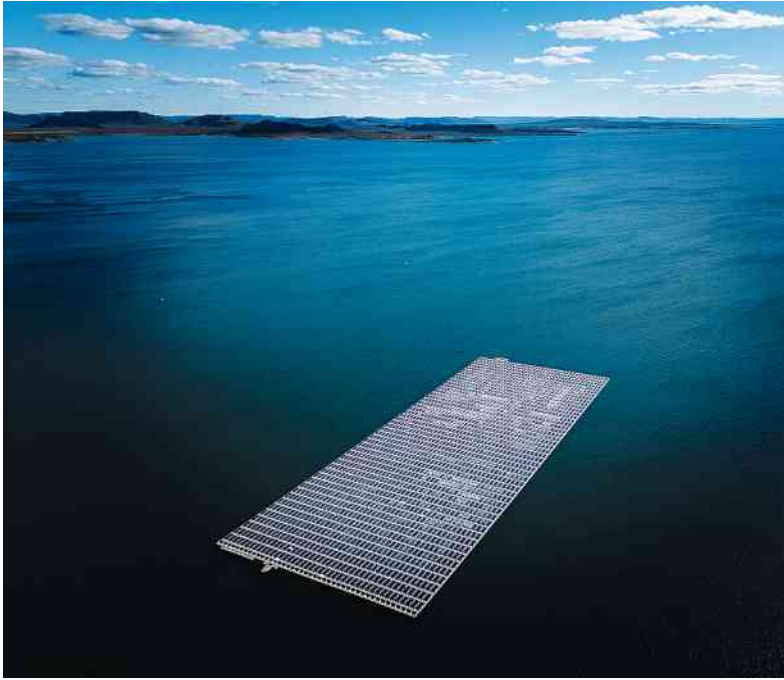
Painéis solares flutuantes perto da barragem de Sobradinho, no rio São Francisco, na Bahia Rubens Cavallari - 29.mai.26/Folhapress
