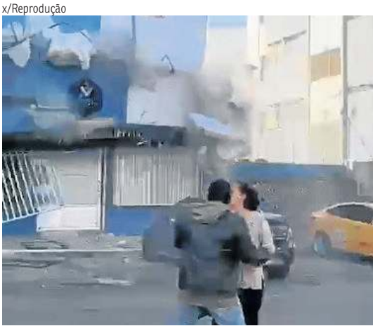
Casal se abraça na rua, enquanto edifício desaba, em Pereira, a área mais afetada pelo desastre
