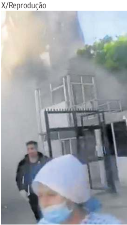
Colapso de hospital, também em Cali
